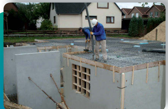
Betonieren
