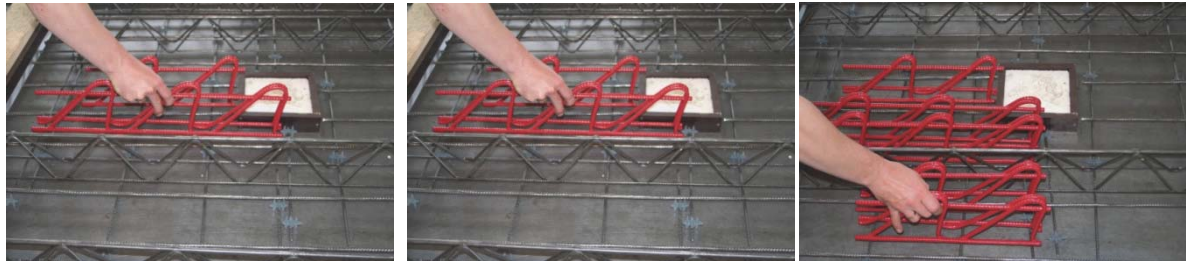
Bild 3: Einbau der FDB II
