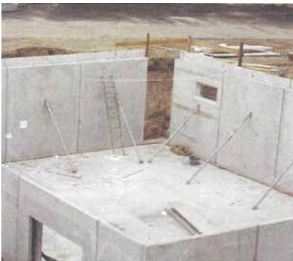
In Verbindung mit den BWS-Elementdecken kann durch Anordnung einer Zusatzbewehrung eine biegesteife Verbindung geschaffen werden.
